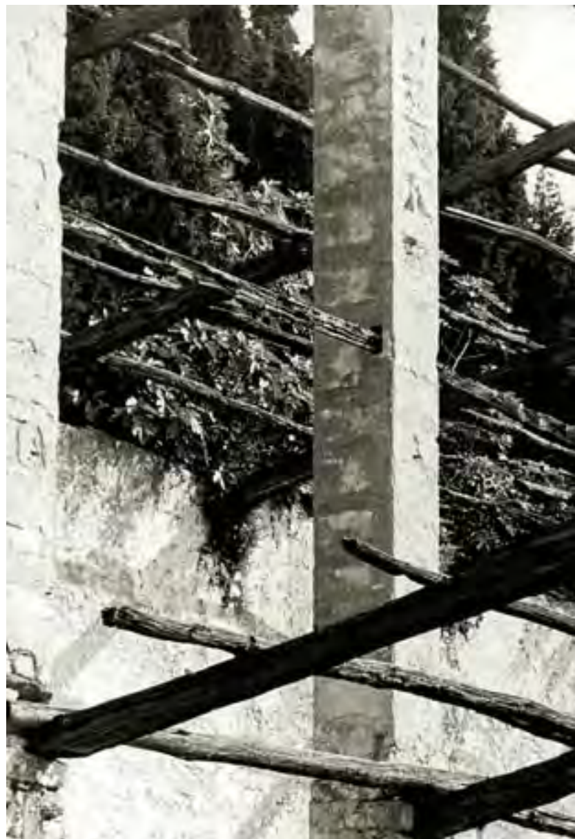
Pilastri, filaröle , sparadòs e cantér .
