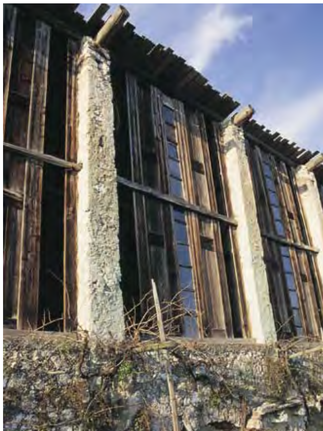
Particolare del fronte solare di una limonaia, con mesì , envédriàe e üsére .
