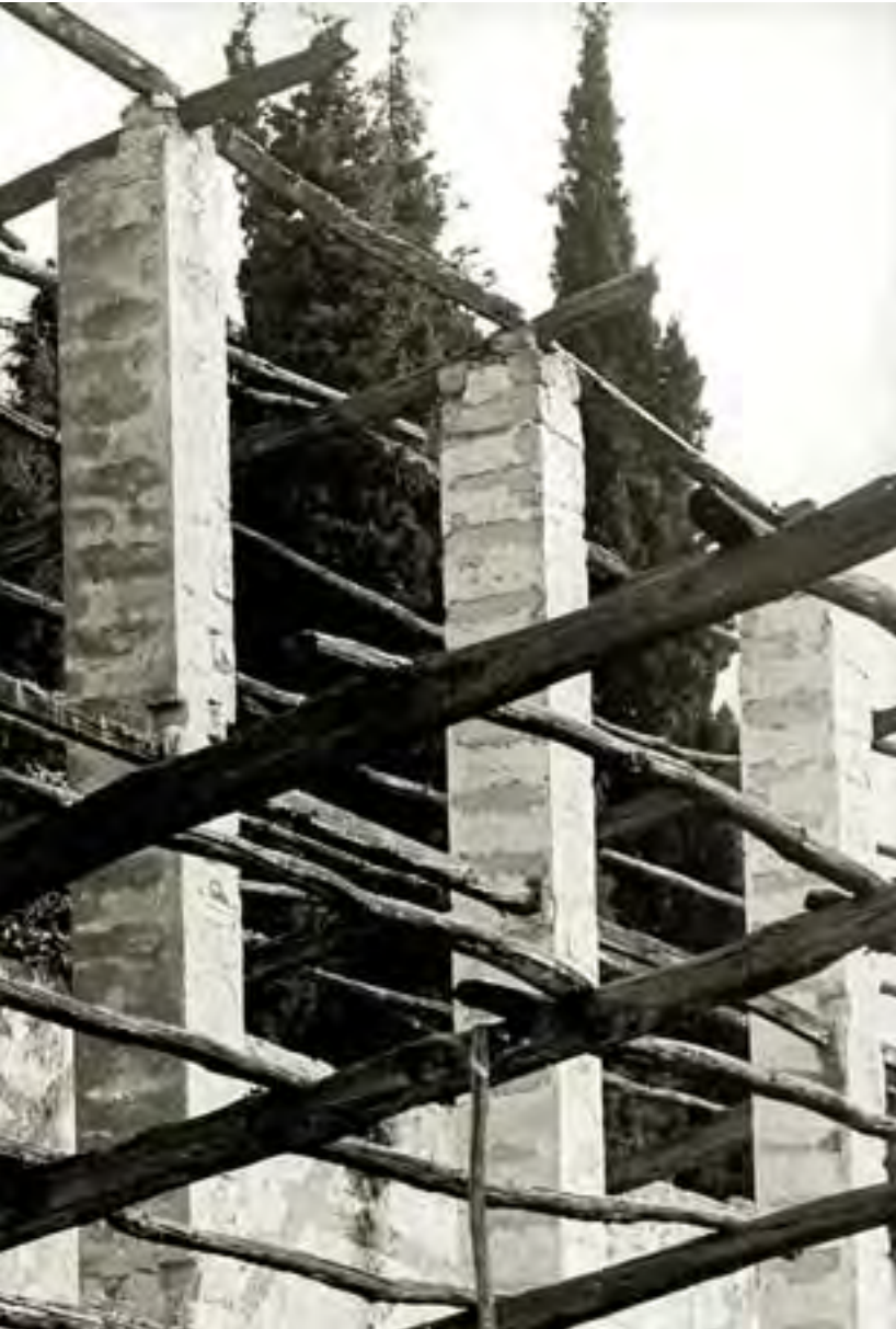
Pillars, filaröle , sparadòs and cantér .
